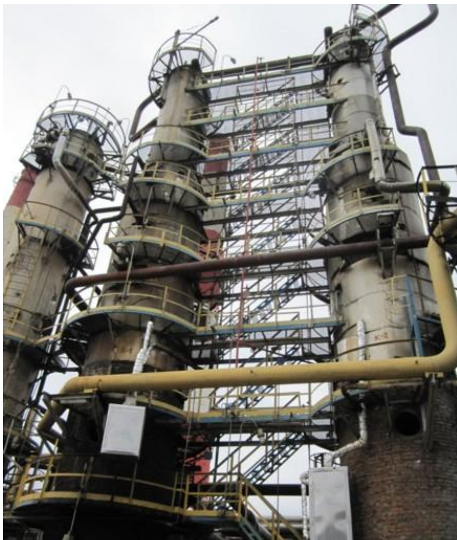
Рисунок 1.1 – Установка гидроочистки нефти Л-24-6
