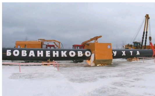
Рисунок 1.1 – Сварка стыка газопровода «Бованенково-Ухта»
