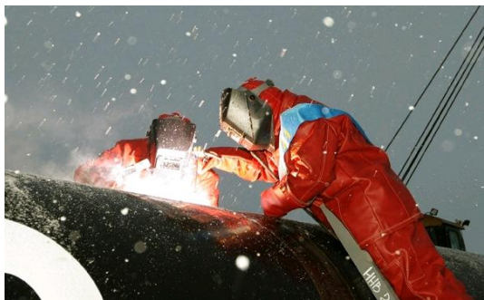
Рисунок 1.1 – Сварка стыка газопровода «Бованенково-Ухта»
