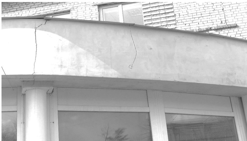
Рисунок 19 – Фото, отображающее поверхности козырька над ВХОДОМ
