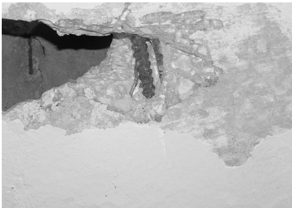
Рисунок 21 – Фрагмент нижней арматуры плиты перекрытия
