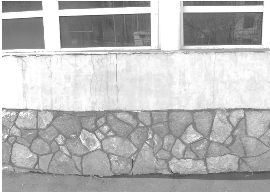
Рисунок 18 – Фото, отображающее поверхности стены
