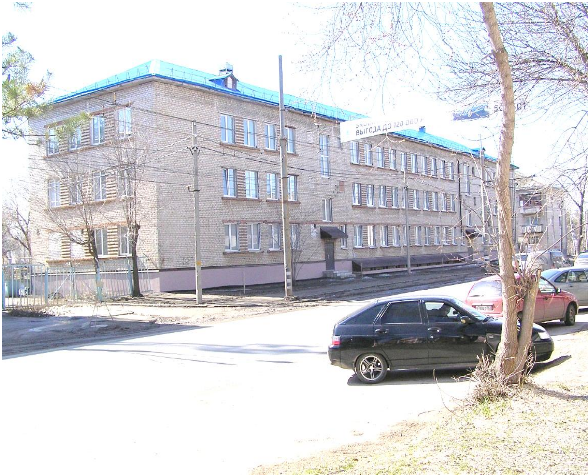
Рисунок 7 – Обследуемое здание со стороны улицы Комзина
