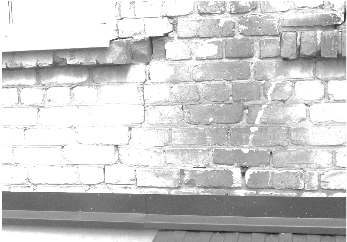
Рисунок 15 – Стена южный фасад
