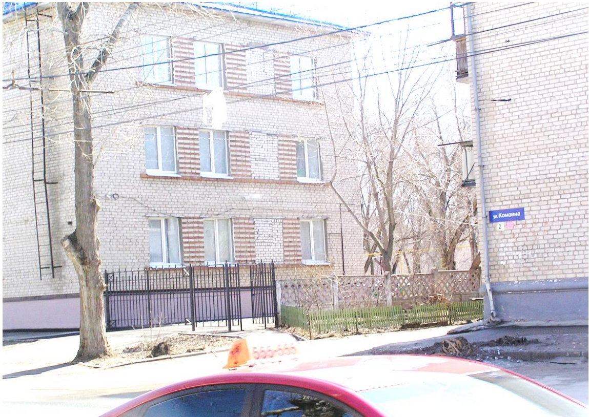
Рисунок 6 – Обследуемое здание восточный фасад
