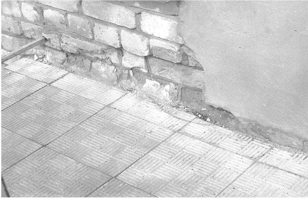
Рисунок 23 – Фото, отображающее разрушение поверхности стены со стороны улицы Комзина
