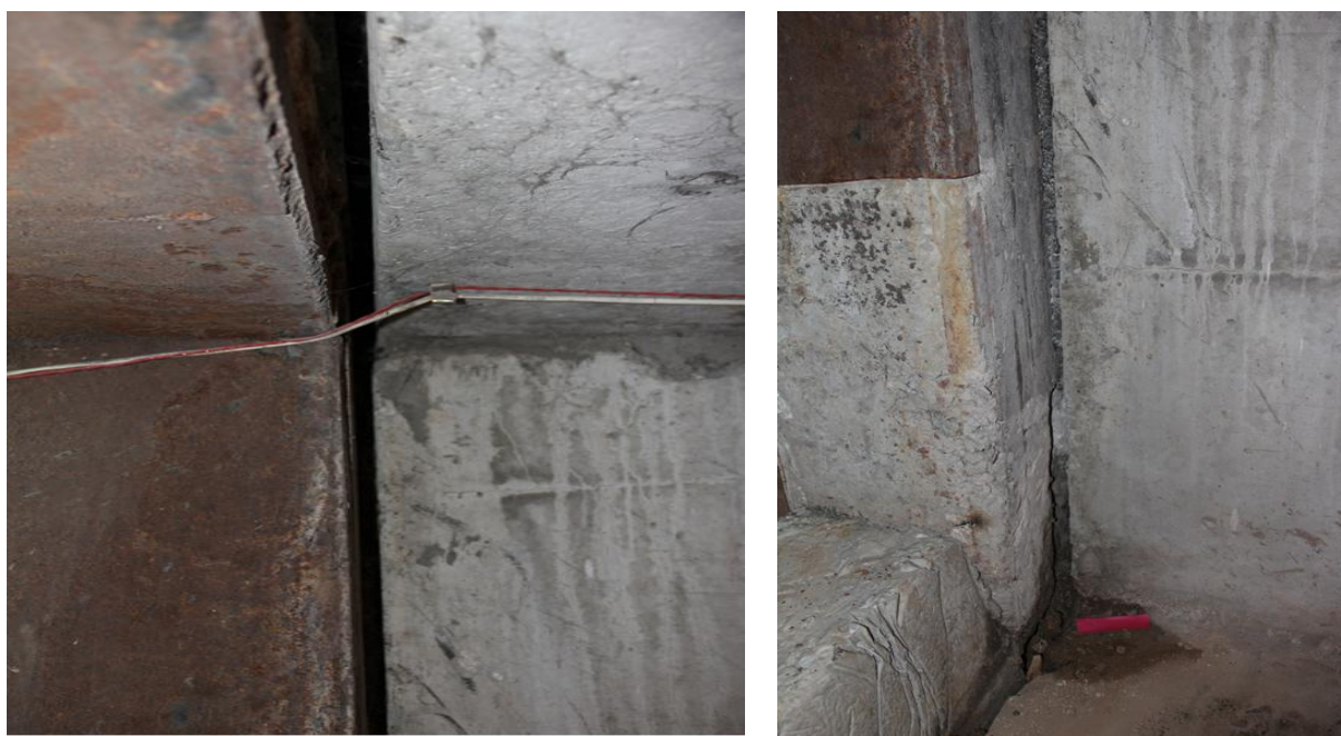
Рисунок 14 - Узел стыковки воздухозаборного тоннеля (справа) с технологическим проёмом (слева) в наружной стене венткамеры (ось К, в рядах 6-7). Верх и низ.
