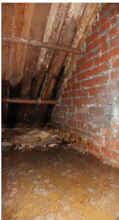
Рисунок 22 - Северное крыльцо. Глухое пространство под ЛМ2: а) наружная стена к ряду 9 (справа), на полу слой воды толщиной около 100 мм, вверху - дощатая опалубка ЛМ2; б) Прямо: наружная стена к ряду 9, внизу: самодельный дренажный приямок под насос, отм. -4,600 м.
