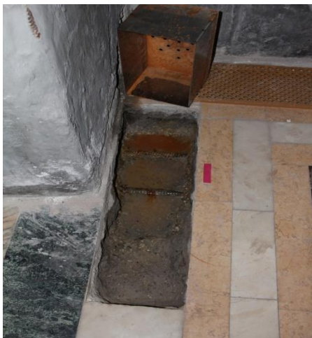
Рисунок 9 - Самодельный дренажный приямок. а) Северная сторона, б) Южная сторона (ось В, в рядах 8-9)
