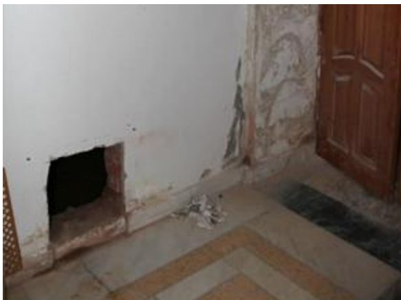
Рисунок 21 - Северное крыльцо. Лаз в кирпичной перегородке под ЛМ2.
