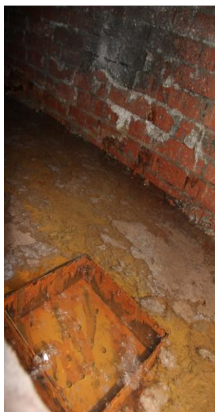
Рисунок 22 - Северное крыльцо. Глухое пространство под ЛМ2: а) наружная стена к ряду 9 (справа), на полу слой воды толщиной около 100 мм, вверху - дощатая опалубка ЛМ2; б) Прямо: наружная стена к ряду 9, внизу: самодельный дренажный приямок под насос, отм. -4,600 м.
