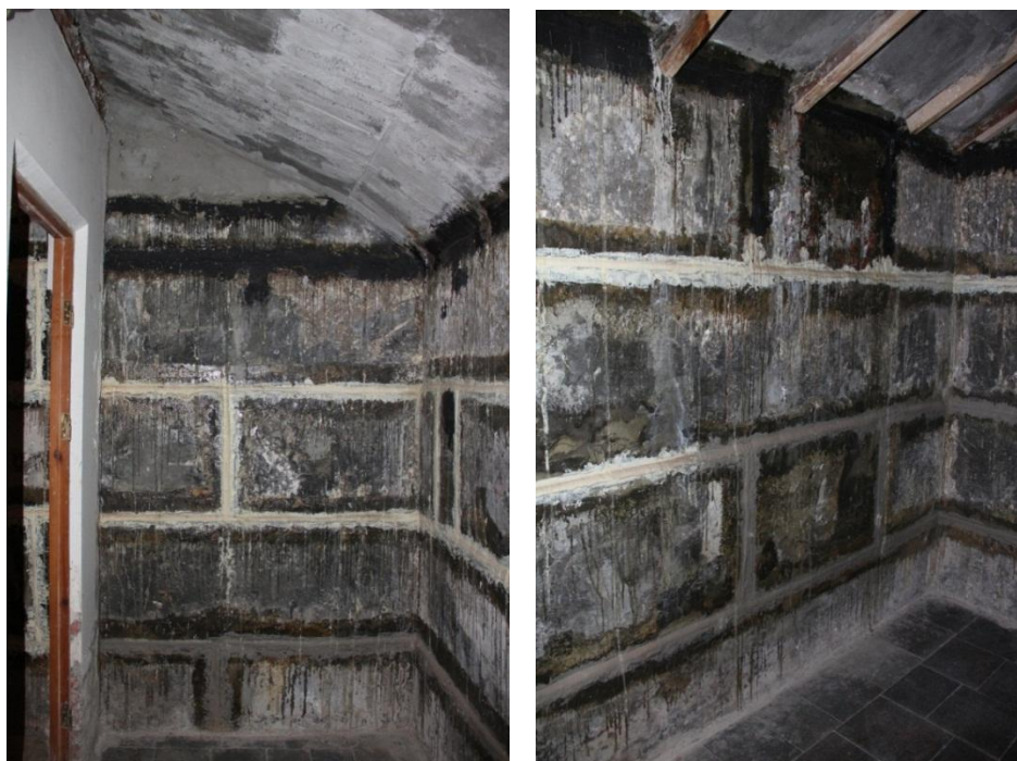
Рисунок 23 - Вид выполненных работ по разшивке и заделыванию швов материалом Вилад 30 в натуре
