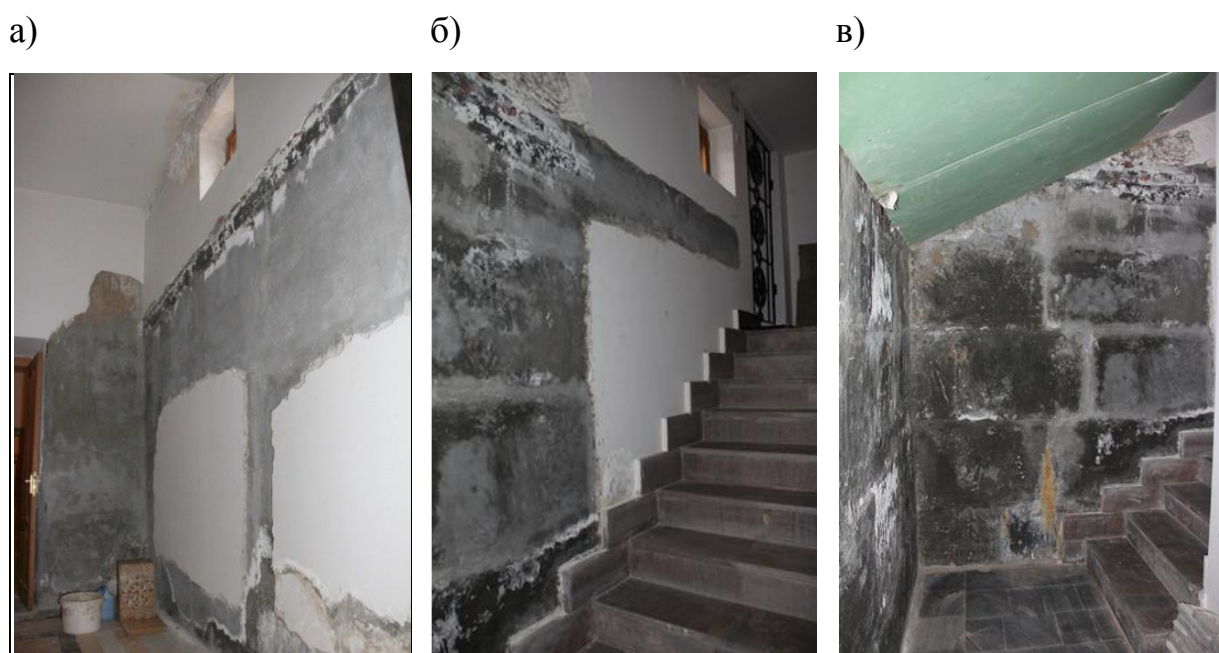
Рисунок 20 - Северное крыльцо: а) наружная стена к ряду 8 (справа); б) наружная стена к ряду 9 (слева), в) Лестничный марш Лм2 на отм. -4,320 м на отм. -2,520 м.
