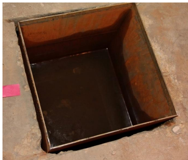
Рисунок 15 - Воздухозаборный тоннель: а) защитный бетонный порог; б) дренажный приямок в полу тоннеля.
