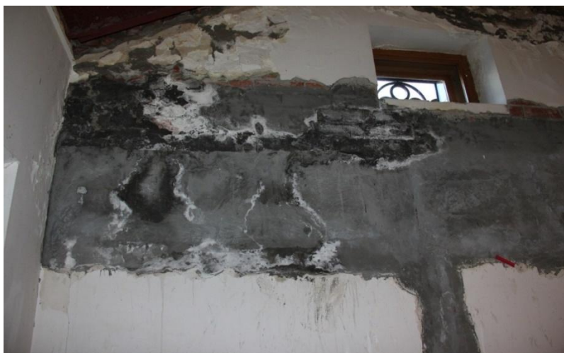
Рисунок 17 - Южное крыльцо. Верхняя часть наружной стены к ряду 8
