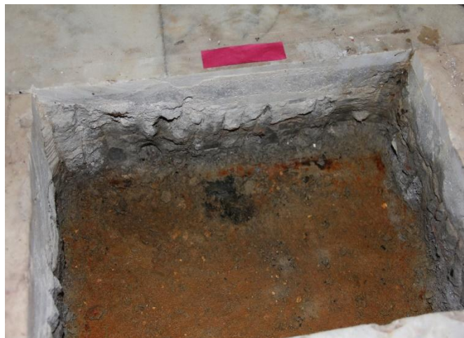
Рисунок 9 - Самодельный дренажный приямок. а) Северная сторона, б) Южная сторона (ось В, в рядах 8-9)
