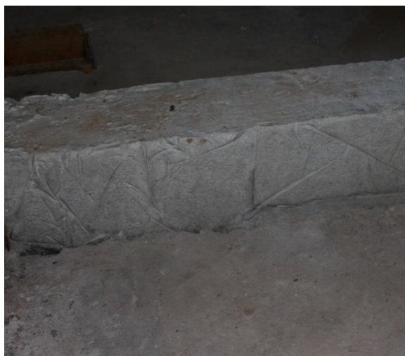
Рисунок 15 - Воздухозаборный тоннель: а) защитный бетонный порог; б) дренажный приямок в полу тоннеля.
