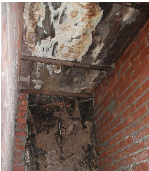
Рисунок 19 - Южное крыльцо. Глухое пространство под Лм2. Прямо: наружная стена Собора (ось Г). Слева: перегородка. Справа: наружная стена крыльца к ряду 9. Вверху: дощатая опалубка. Внизу: строительный мусор.
