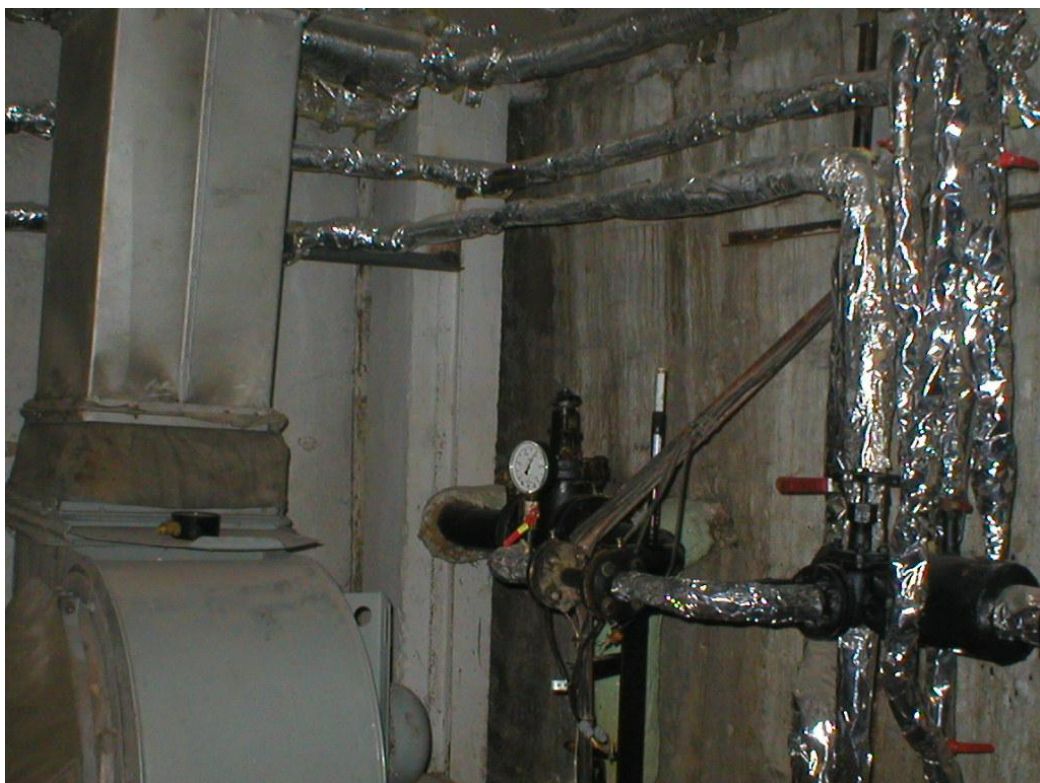
Рисунок – А.2 Состояние стен по оси «33» в вентиляционной камере
