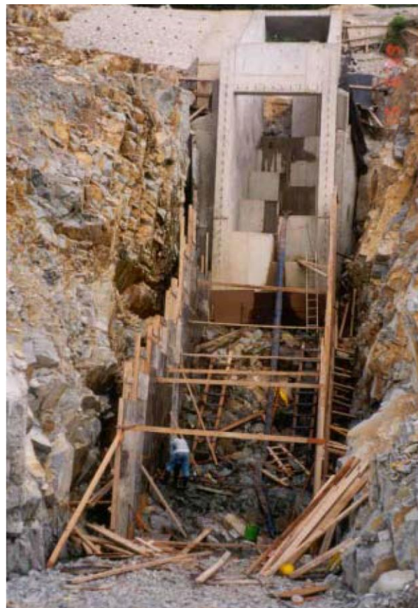
Рисунок 3.1. Укрепление основания.
