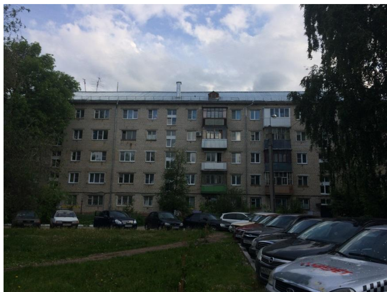
Рисунок 34- Фасад здания до реконструкции
