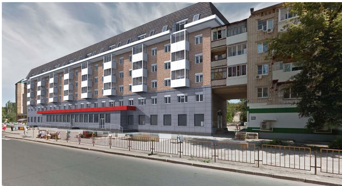
Рисунок Б3 - Визуализация реконструкции фасада с надстройкой мансардного этажа в Центральном районе г. Тольятти
