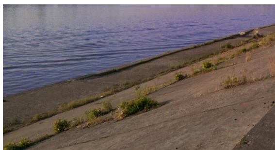
Рисунок 2.21 – Выкладка на берегу бетонных плит
