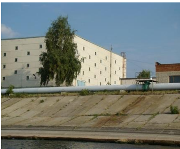
Рисунок 3.2 – Станция "Водозабор" ООО "АВК". Вид с водохранилища
