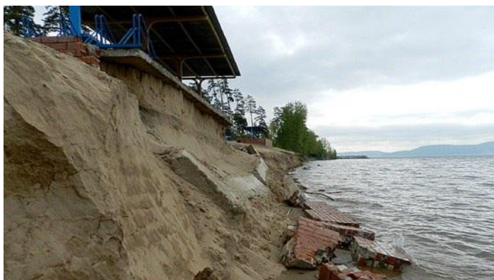
Рисунок 3.4 – Образовавшийся обрыв, высота которого достигает 2 м.
