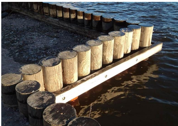
Рисунок 2.19 – Укрепление берега деревянными сваями
