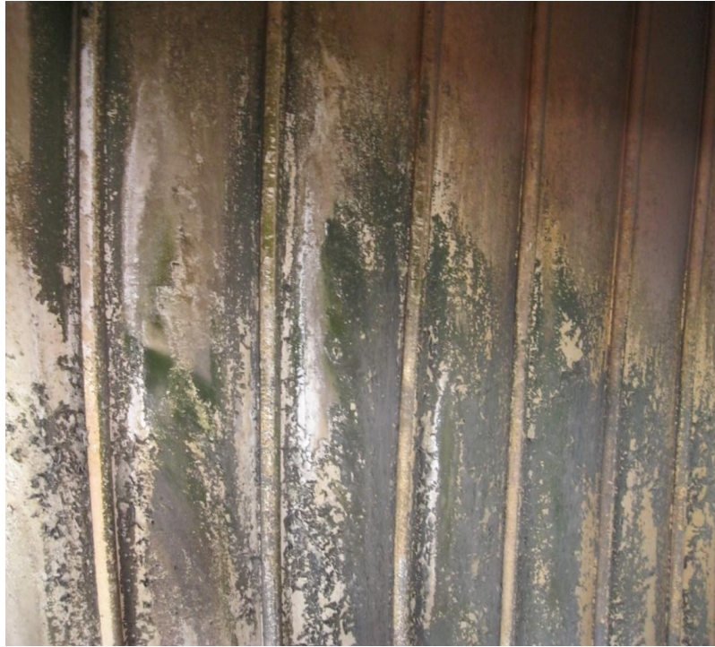
Рисунок 1.2 – Водоросли на стенке технологического оборудования
