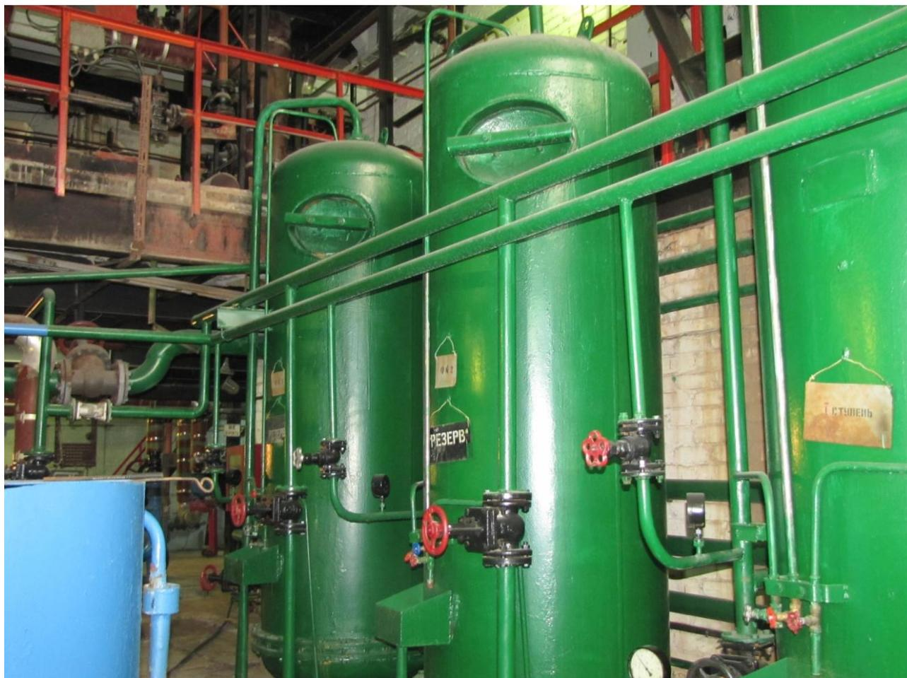
Рисунок 18 - Na-катионитовые фильтры завода ОАО «ТКЗ»
