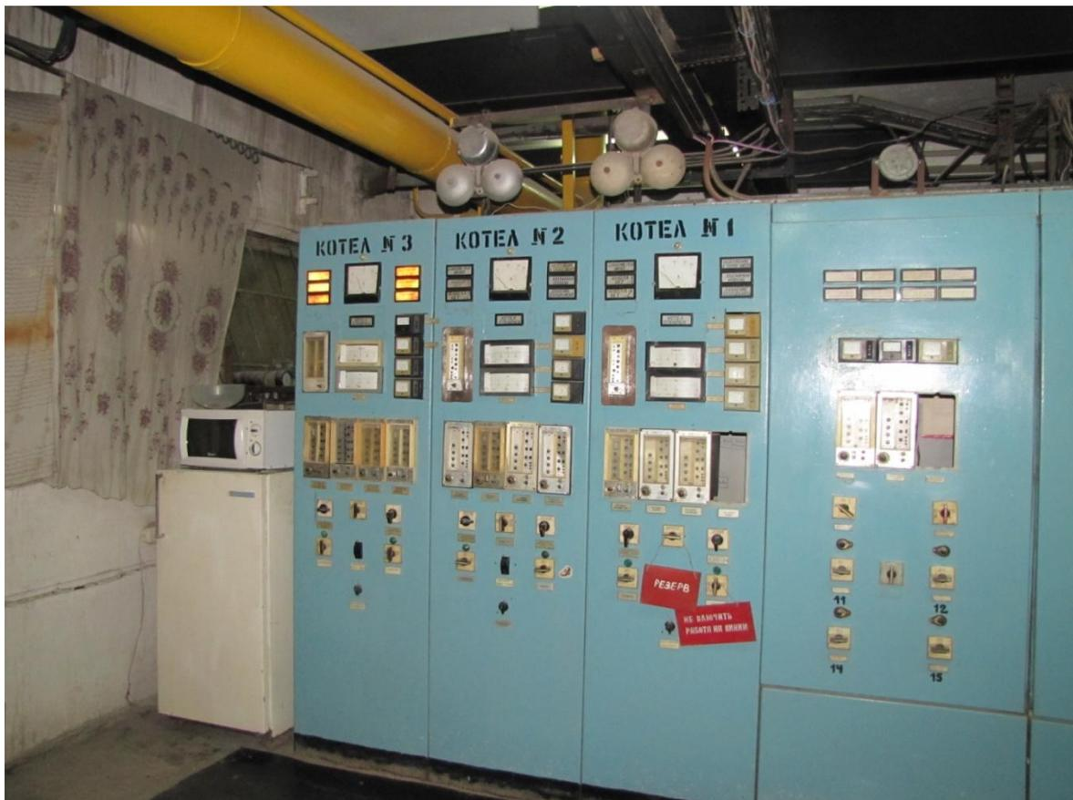
Рисунок 16–Аппараты для вывода информации о работе котлов на ОАО «ТКЗ»
