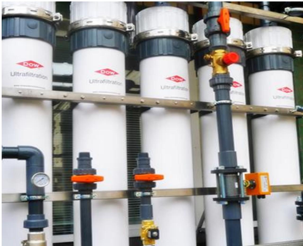
Рисунок 7 - Установка ультрафильтрации
