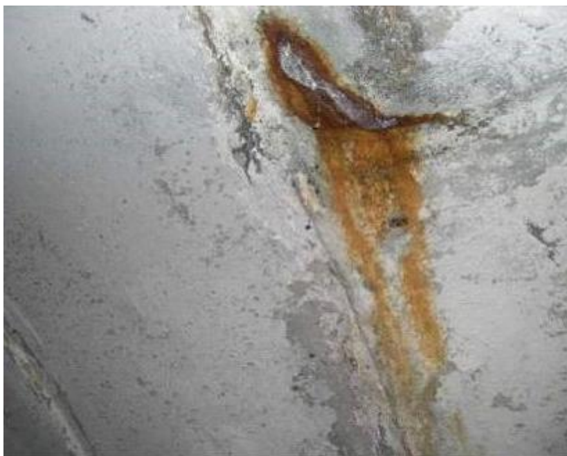
Рисунок 3.8-Процесс разрушения цементно-песчанного покрытия канализационного трубопровода
