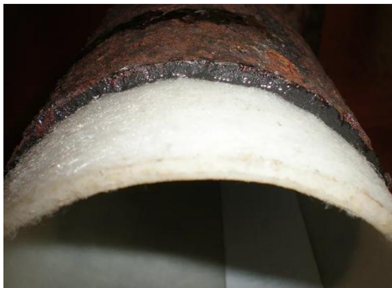
Рисунок 1.11- Восстановленный водопровод при помощи полимерного рукава
