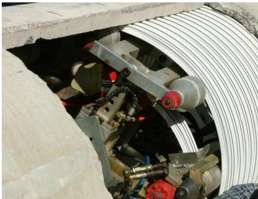
Рисунок 1.12 Работа установки по навивке ленты
