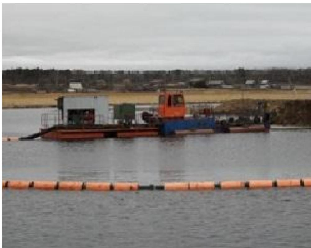
Рисунок 3.4— Работа земснарядов по очистке водоема от ила
