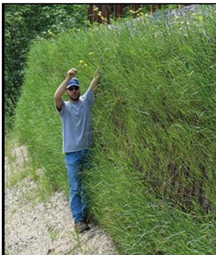
Рисунок — 3.2 Посадка растений на габийонных конструкциях
