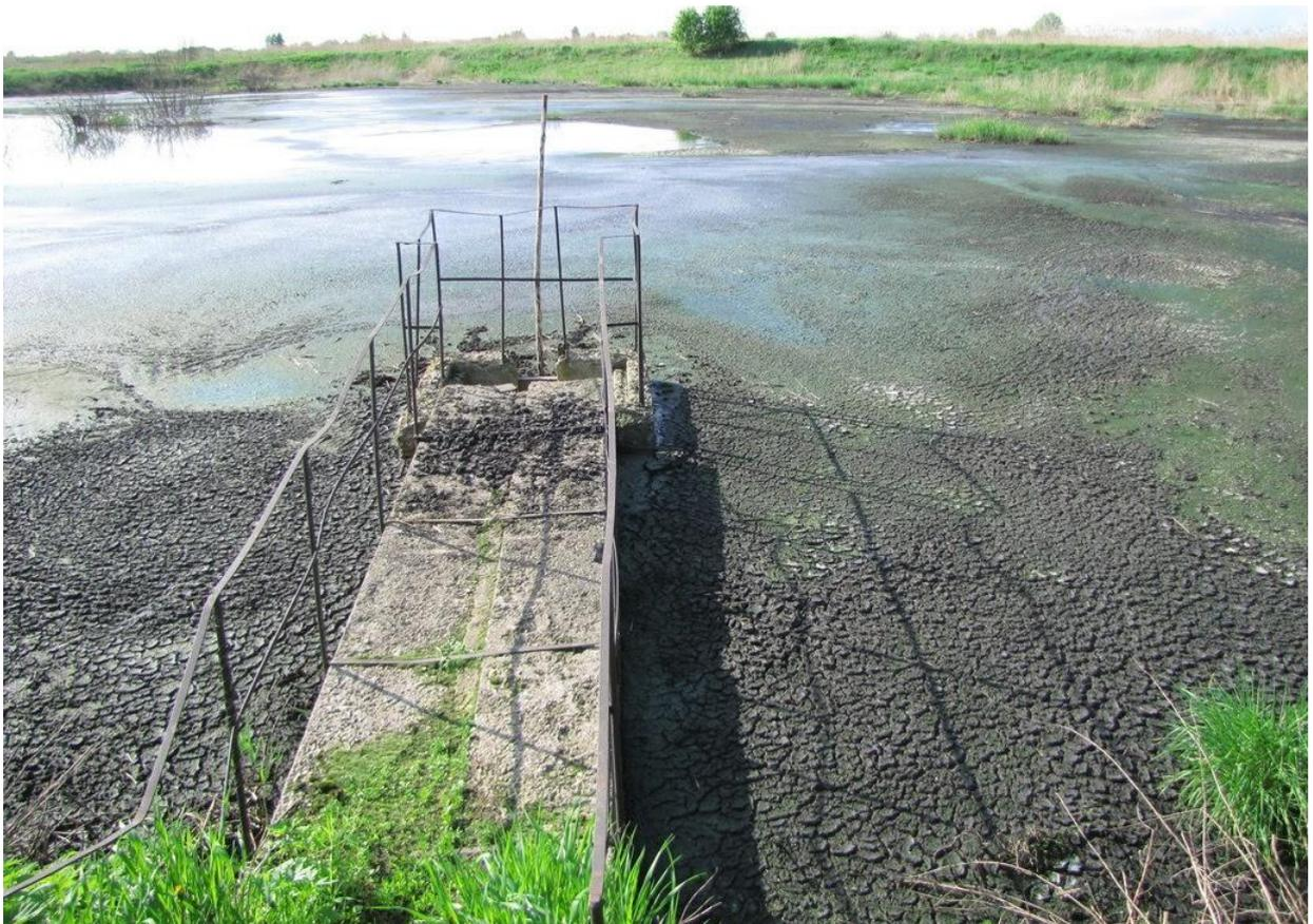
Рисунок 2.3—Сплошной залив на полях фильтрации
