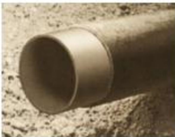
Рисунок 2.6 – Новая ПЭ труба в старой, после принятия первоначальной формы
