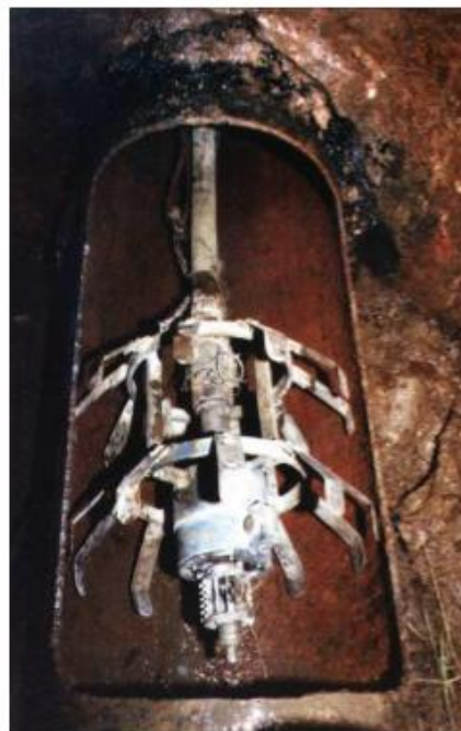
Рисунок 2.1 – Устройство для центробежного набрызга цементно-песчаного раствора
