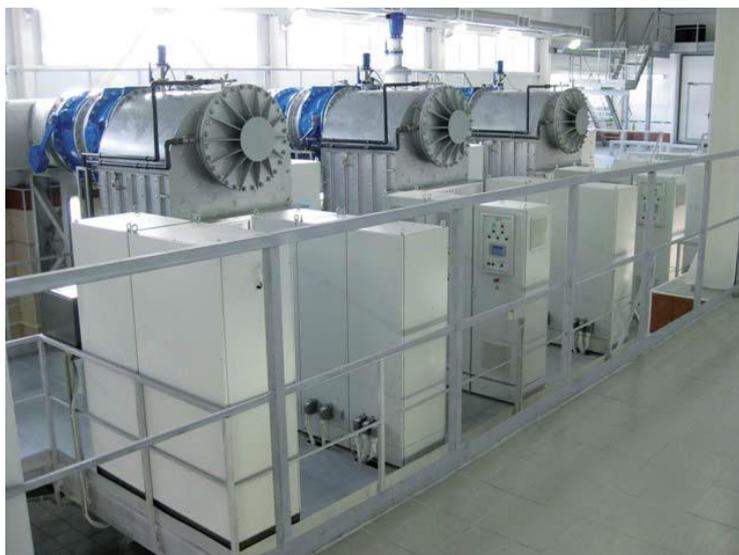
Рисунок 2.9 – Блок УФ-установок
