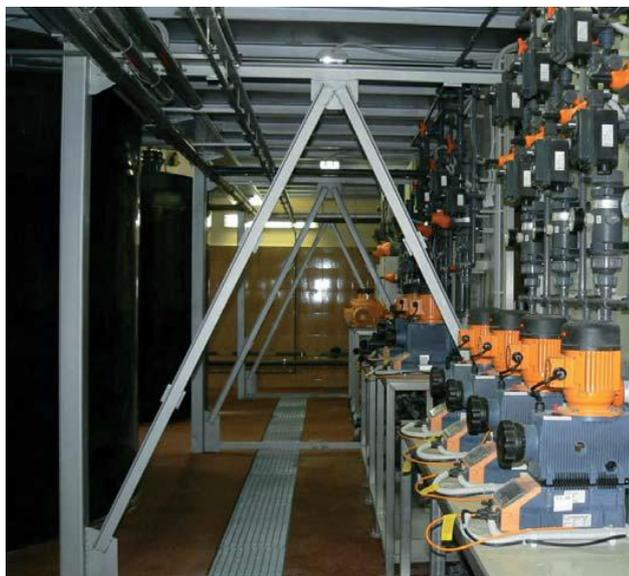
Рисунок 2.7 – Станция обеззараживания воды с использованием гипохлорита натрия
