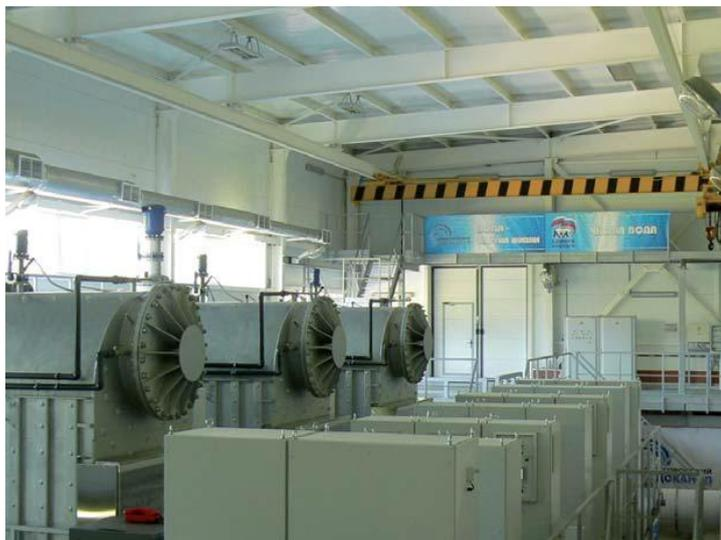
Рисунок 2.8 – Станция ультрафиолетового обеззараживания воды
