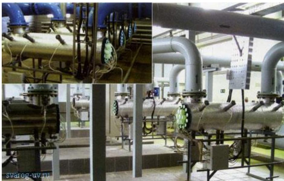
Рисунок 1.12 – УФ-установки обеззараживания с технологией совмещения ультрафиолетового излучения и ультразвука
