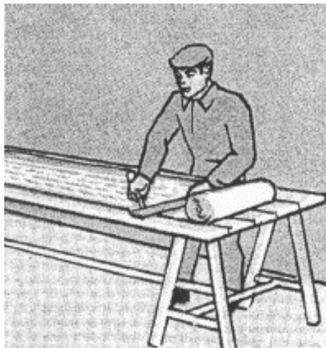
Рисунок 3.4 – Разметка и нарезка полотнищ
