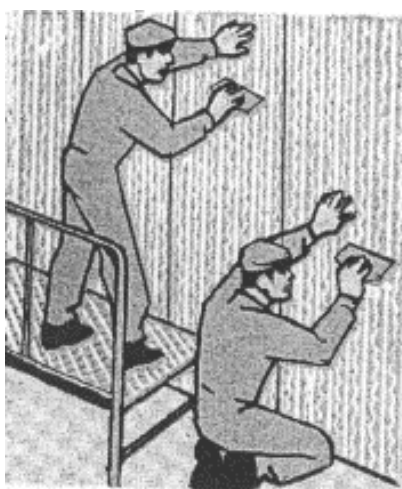
Рисунок 3.7 – Оклеивание поверхностей полотнищами виниловых обоев
