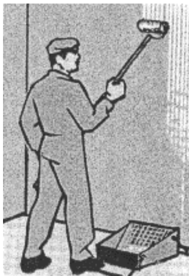
Рисунок 3.5 – Нанесение состава на основе клея KleoSmart на поверхность стен, перегородок
