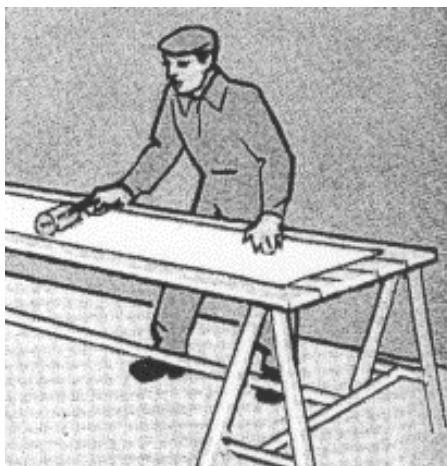
Рисунок 3.6 – Нанесение состава на основе клея KleoSmart на полотнище виниловых обоев
