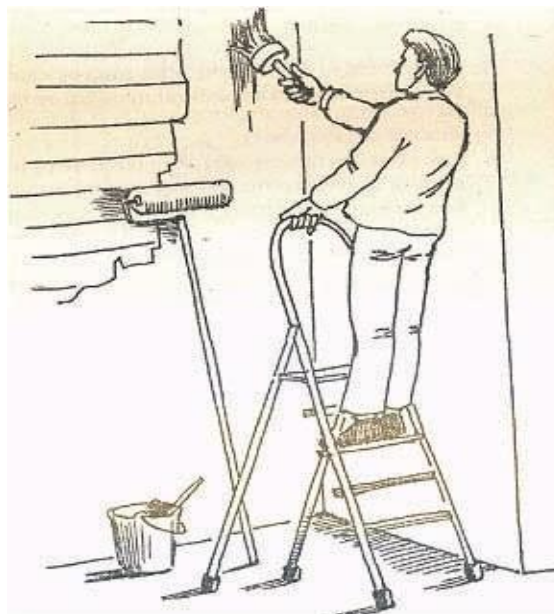
Рисунок 3.1 Окраска труднодоступных мест.
