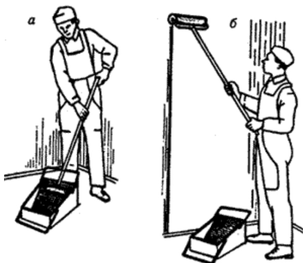
Рисунок 3.2 Окраска стен валиком
