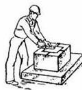
Рисунок 3.1– Нанесение рисок на стакан фундамента
