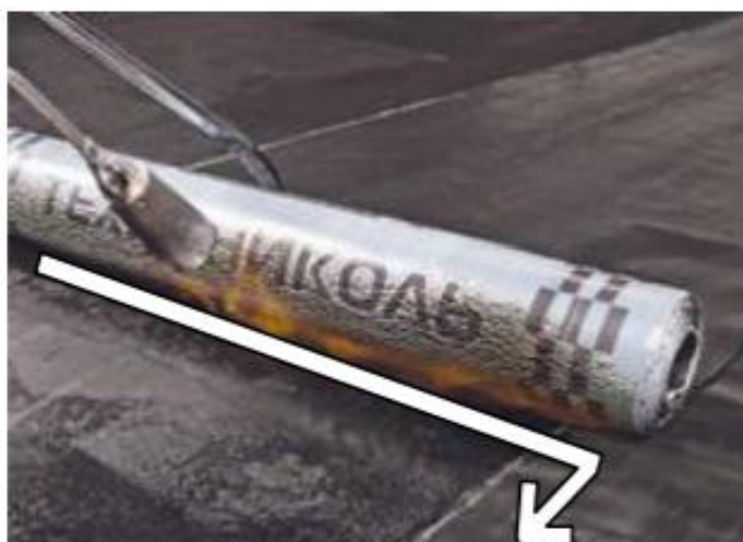
Рисунок 6 – Движение горелки при наплавлении смежных рулонов
