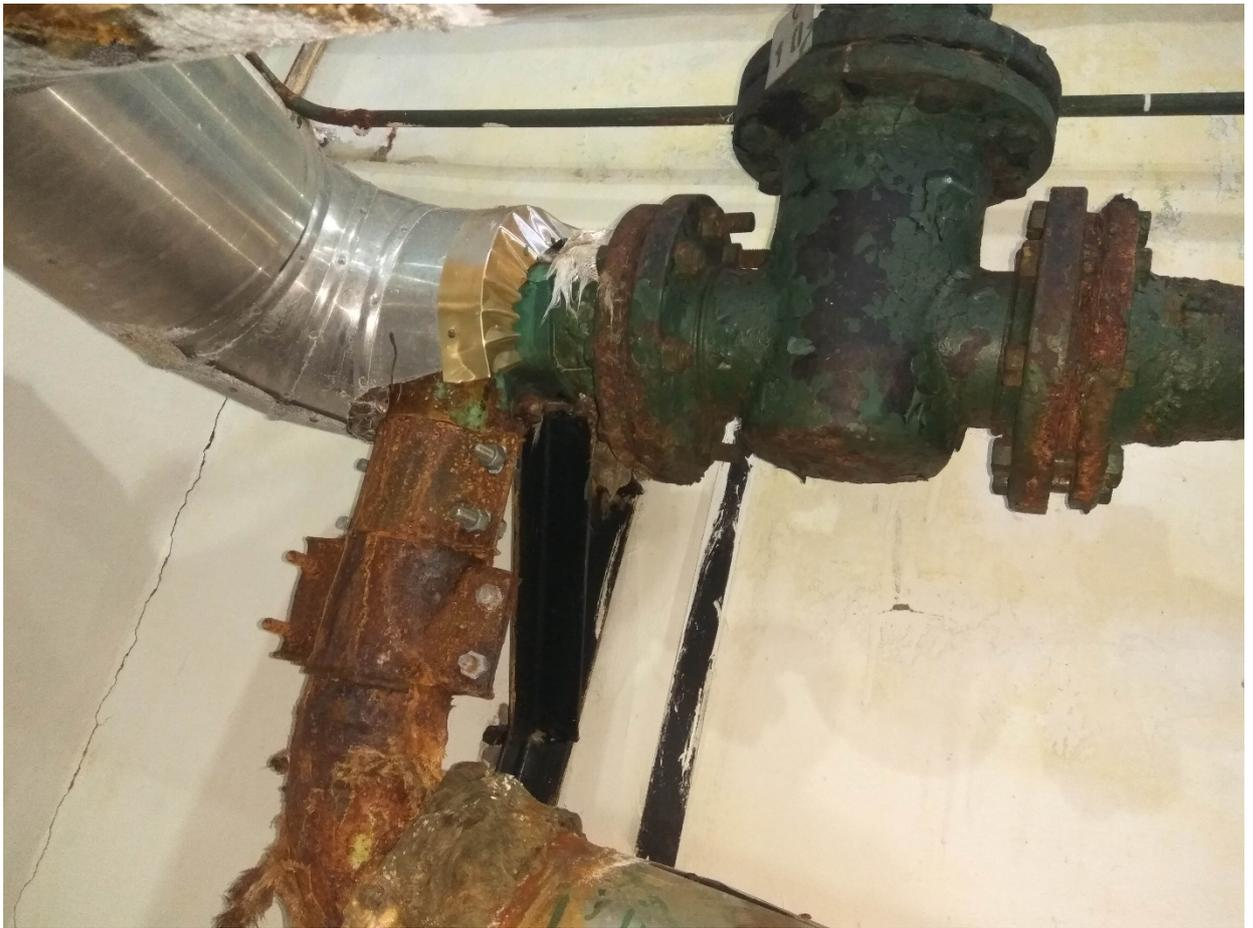
Рисунок 11 – Трубопровод со снятой теплоизоляцией
