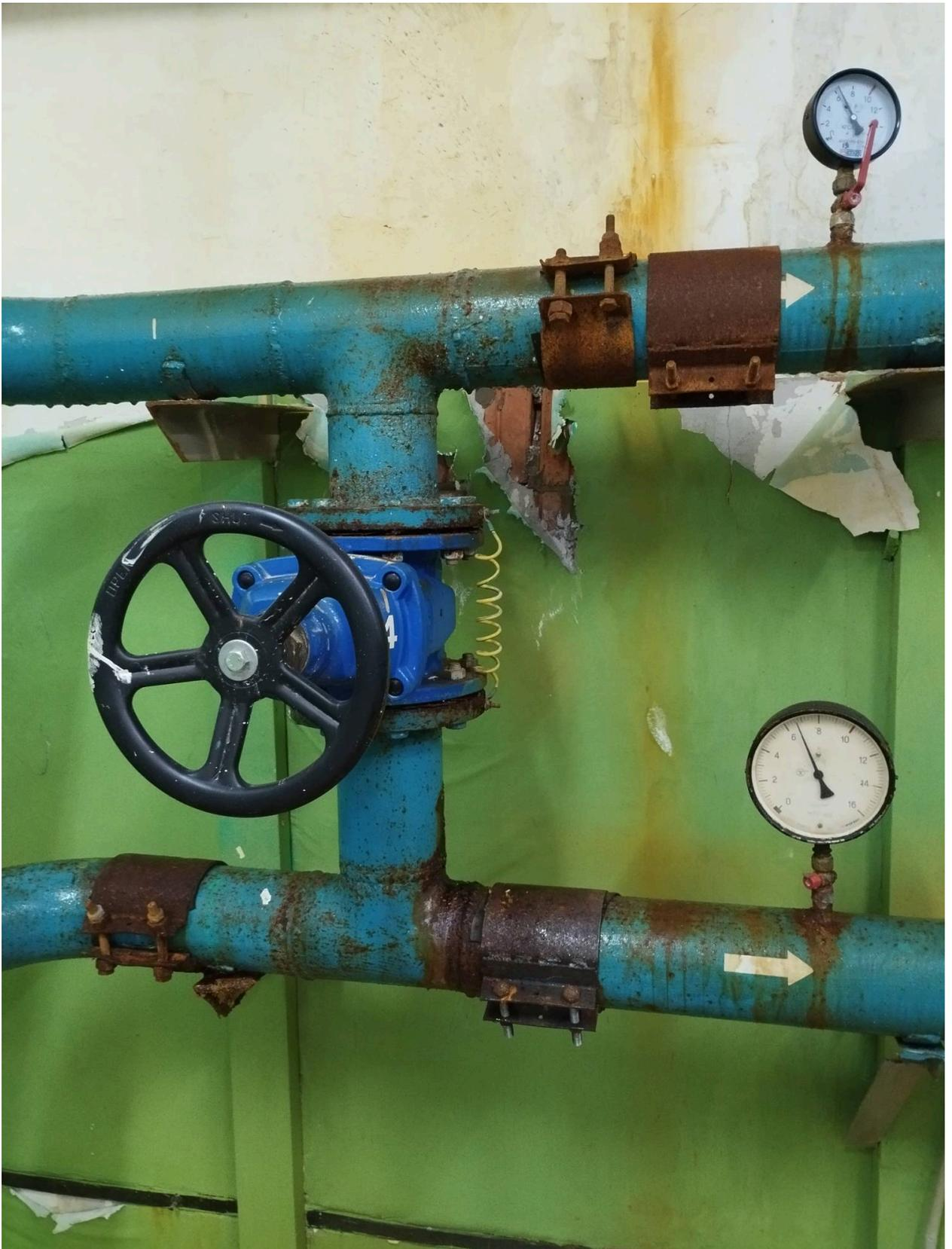
Рисунок 8 – Трубопроводы с хомутами
