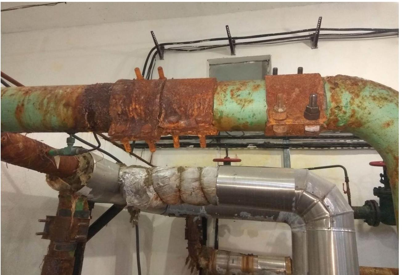
Рисунок 13 – Теплоизоляция полностью снята
