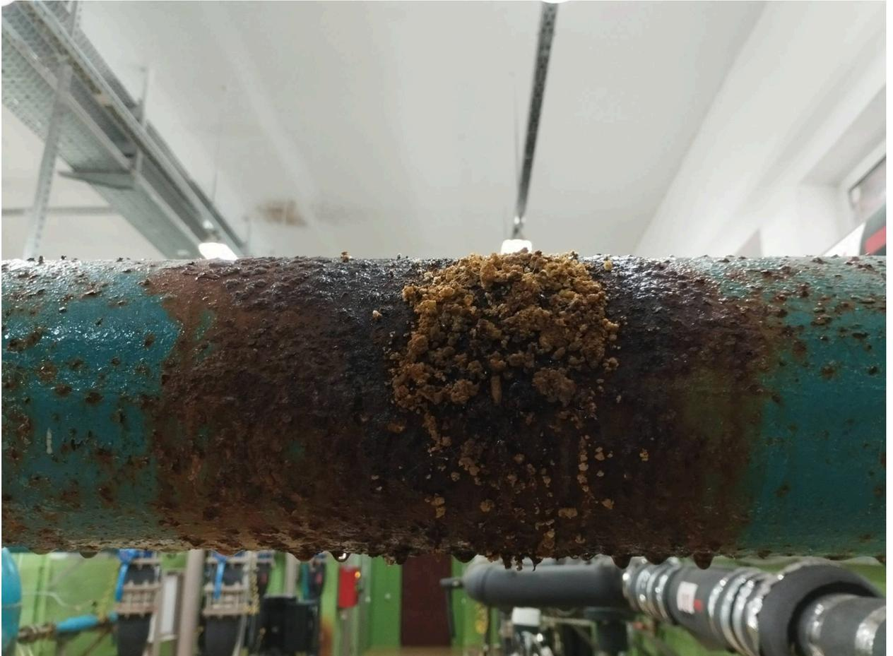
Рисунок 7 – Участок длительной коррозии
