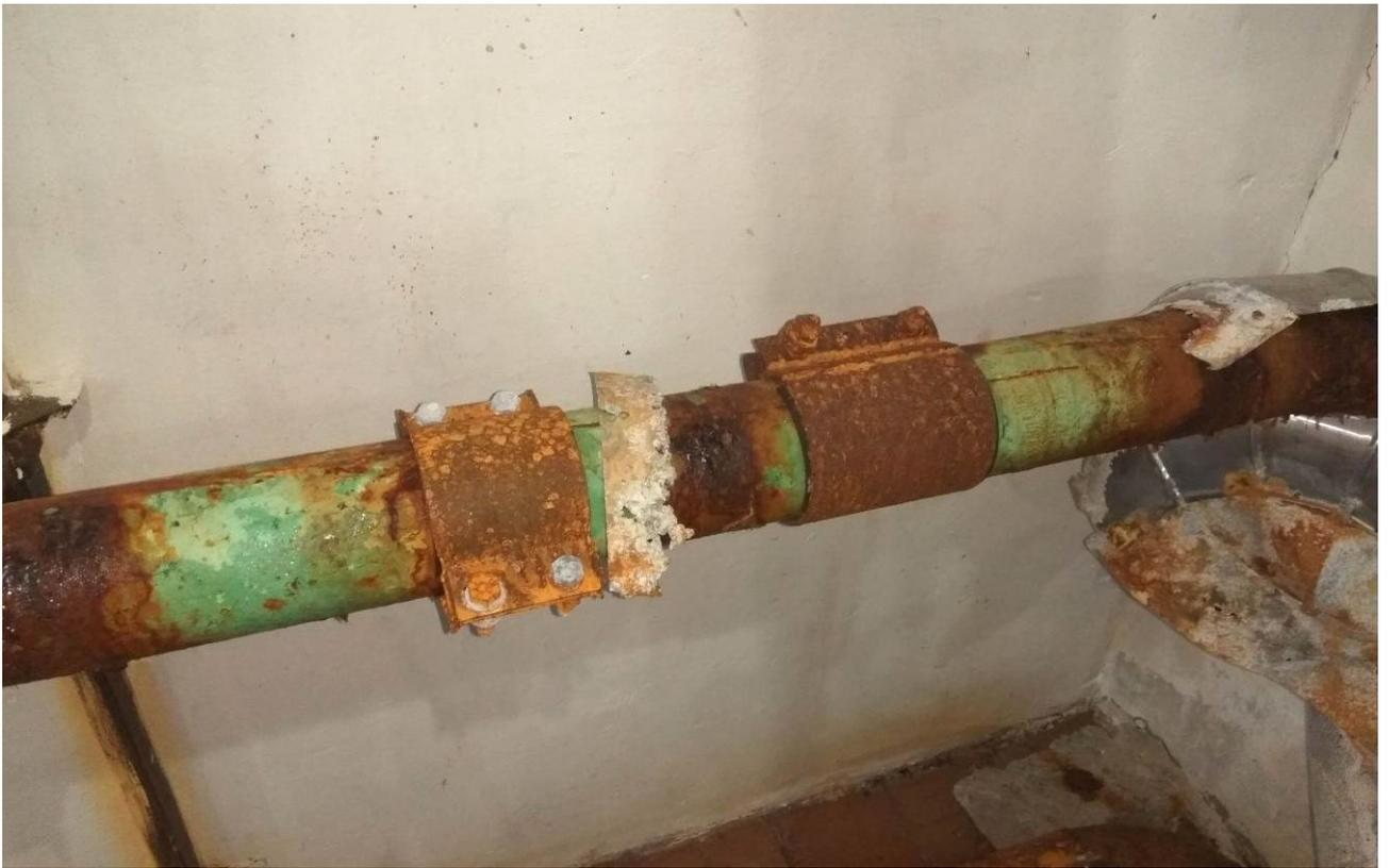
Рисунок 12 – Трубопроводы с частично снятой теплоизоляцией
