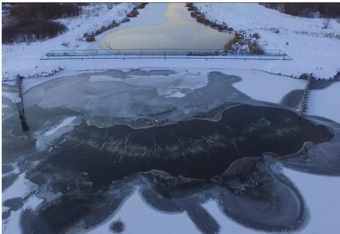
Рисунок 16 – Незамерзающая полынья в зоне работы РЗУ типа «водовоздушная завеса»
