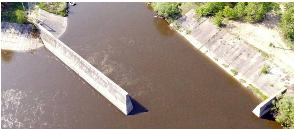
Рисунок 21 – Ледоотбойное сооружение и шпора
