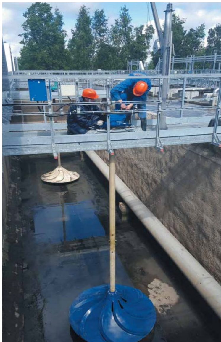
Рисунок 4 – Установка мешалок серии «Mix GMS» на объекте очистки сточных вод (подготовка к испытаниям)
