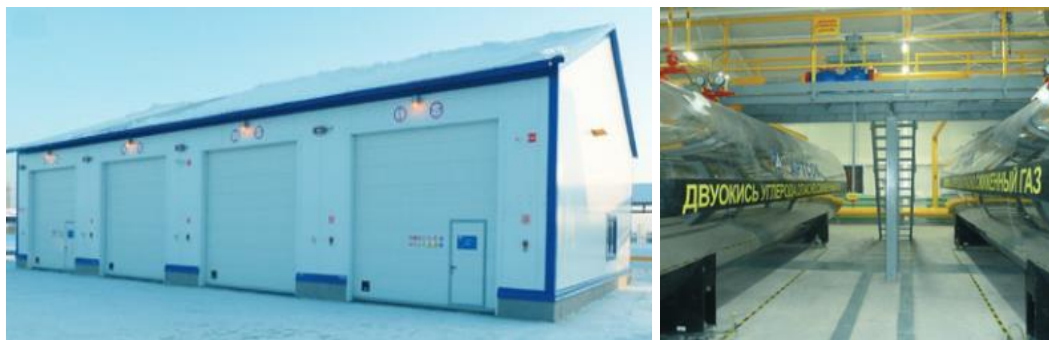
Рисунок 1 – Здание станции газового пожаротушения [17]
