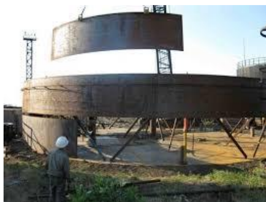
Рисунок 4 – Возведение резервуара методом подрачивания
