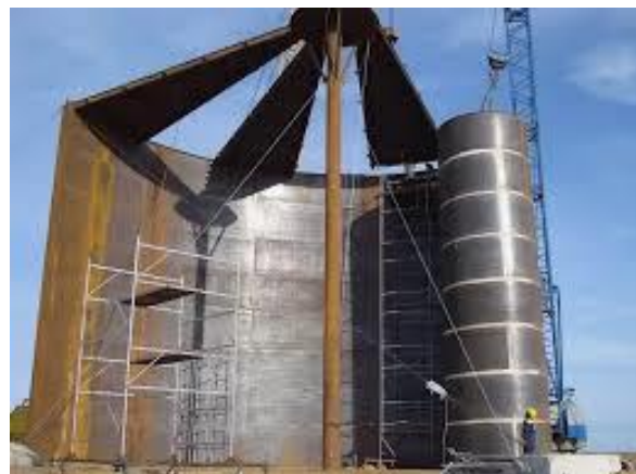
Рисунок 5 – Возведение резервуара методом рулонирования
