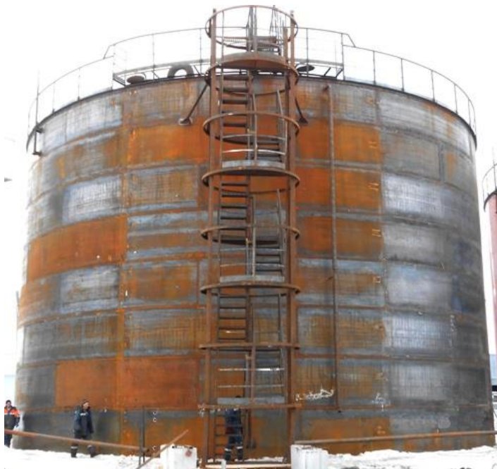
Рисунок 1 – Резервуар объемом пять тысяч кубическим метров
