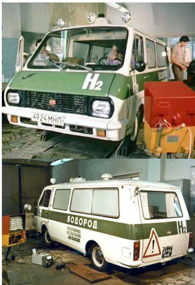
Рисунок 1 – Бензоводородный микроавтобус РАФ-22034 разработки НАМИ
