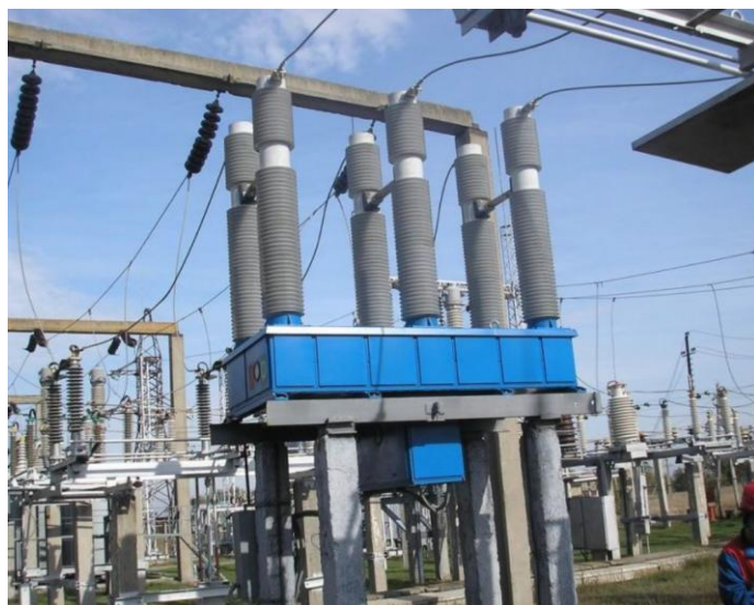
Рисунок 3 – Выключатель 110 кВ
