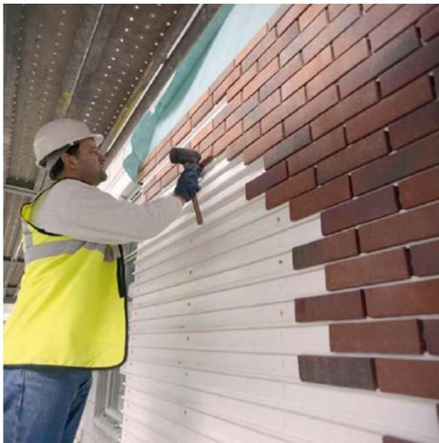
Рис. 4. Системы облицовки кирпичом (Lyons A. Materials for Architects & Builders. Amsterdam [et al.] : Elsevier, 1997)
