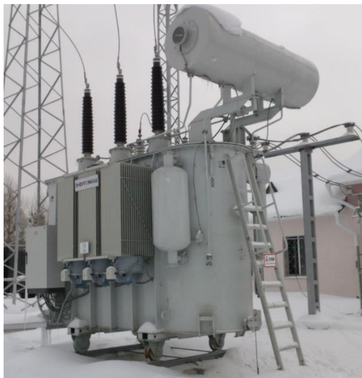
Рисунок 5 – Трансформатор ТДН-10000/110
