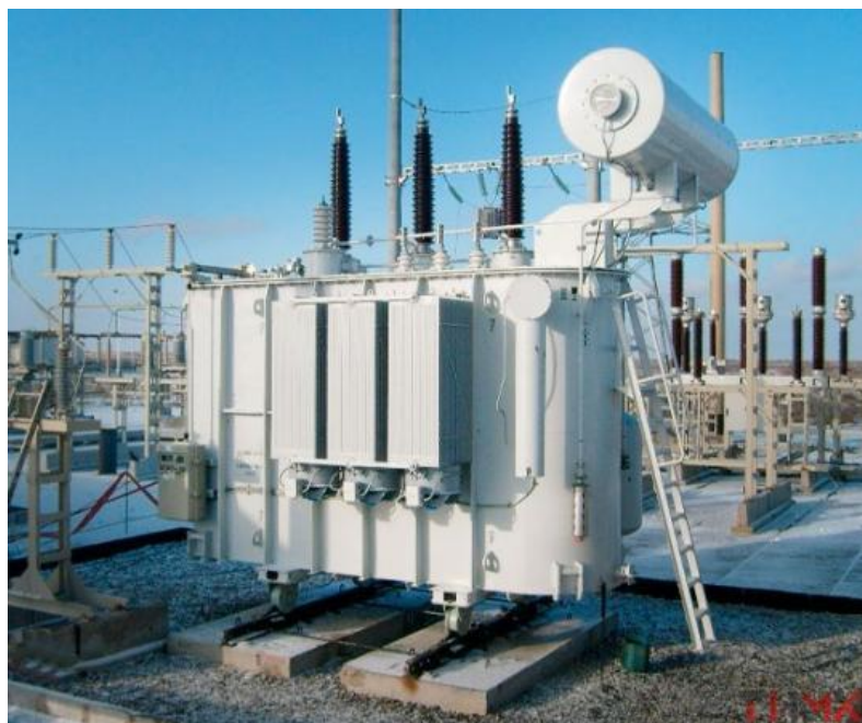
Рисунок 1 – Трансформатор ТДН-16000/110
