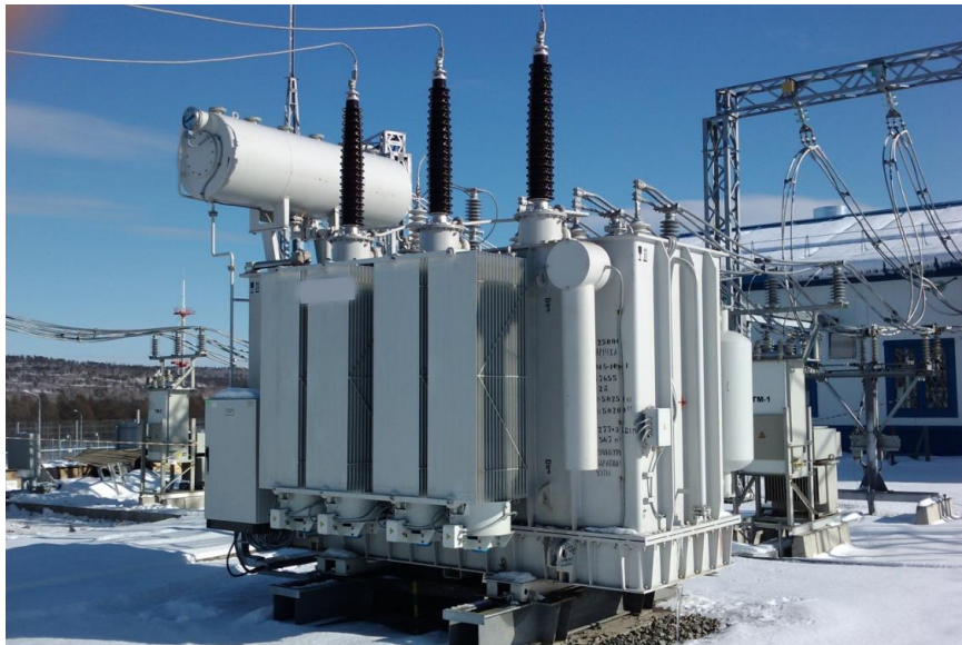
Рисунок 2 – Трансформатор ТДН-25000/110
