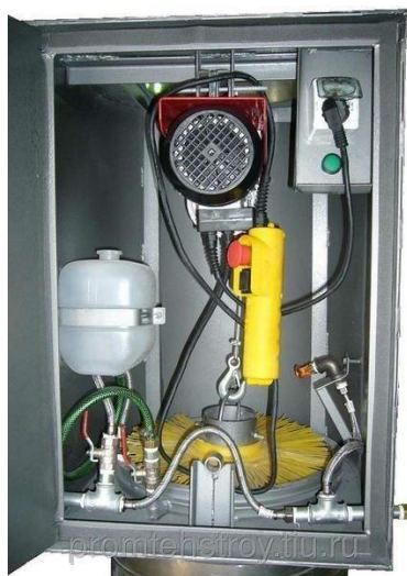
Рисунок 8 – Зачистное устройство мусоропровода
