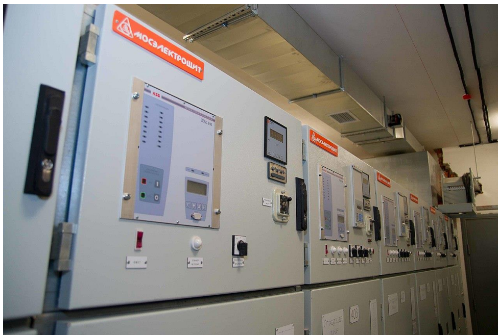
Рисунок 9 – Ячейки КРУ
