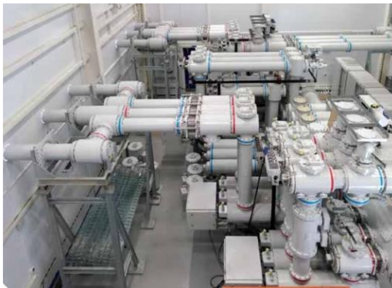
Рисунок 5 – КРУЭ-110 кВ серии ЯГТ-110 АО ВО «ЭЛЕКТРОАППАРАТ»
