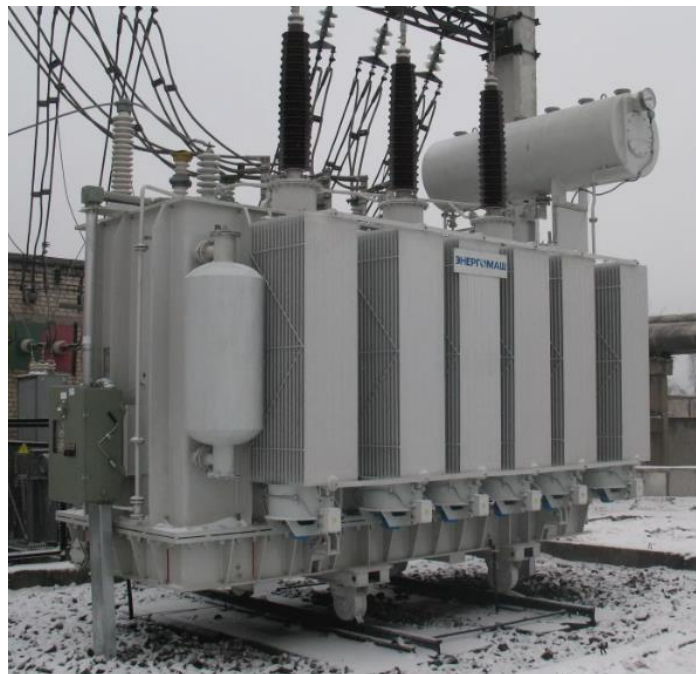
Рисунок 4 – Трансформатор ТМН-6300/110
