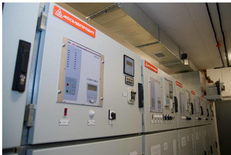
Рисунок 6 – Ячейки КРУ К-132
