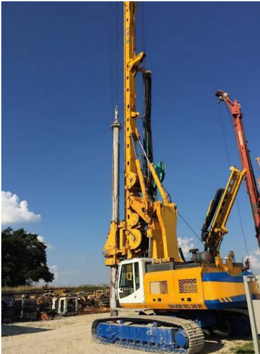
Рисунок 9 – Буровая установка Bauer BG 24 H BT 75
