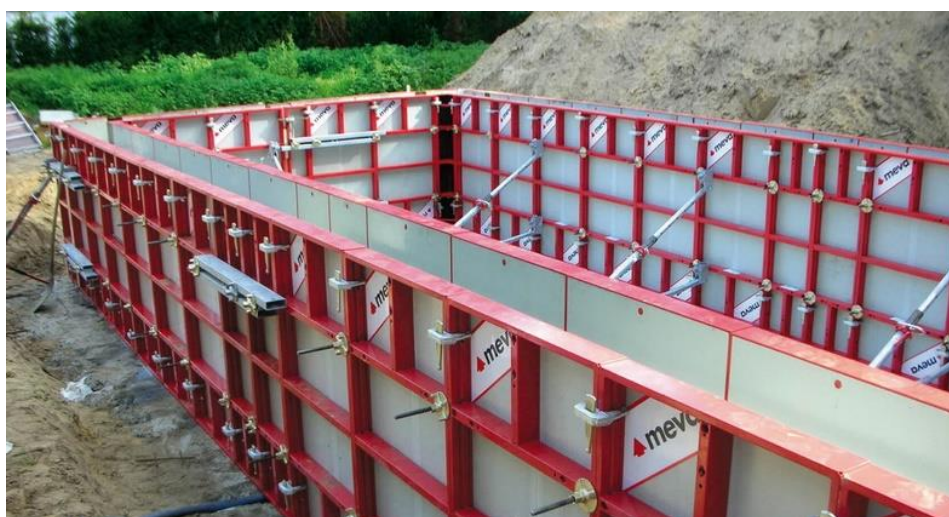
Рисунок 2 – Стальная опалубка
