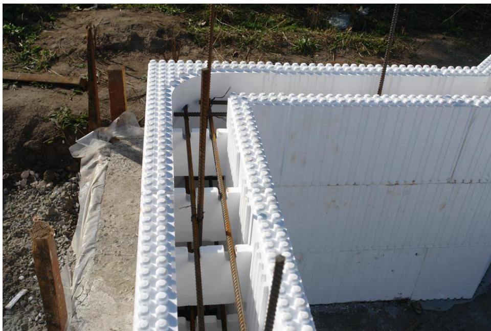
Рисунок 6 – Опалубка из пенополистирола
