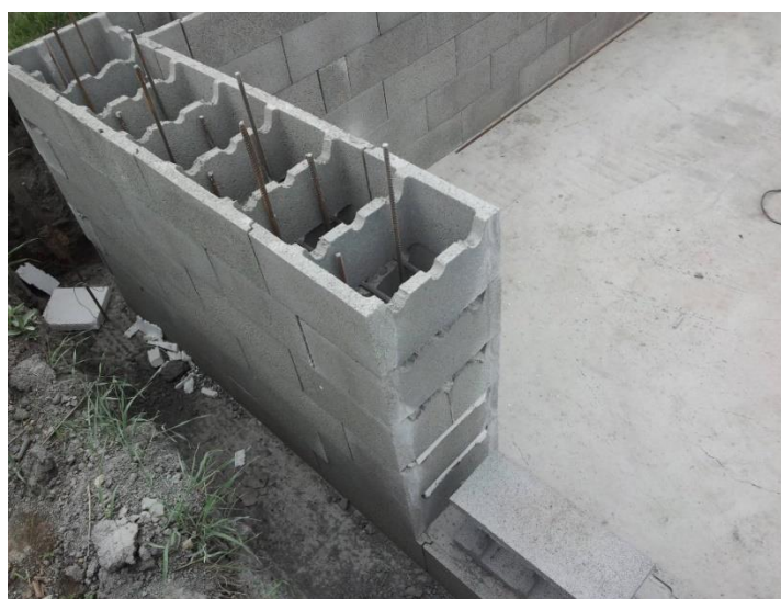
Рисунок 5 – Опалубка из бетонных блоков
