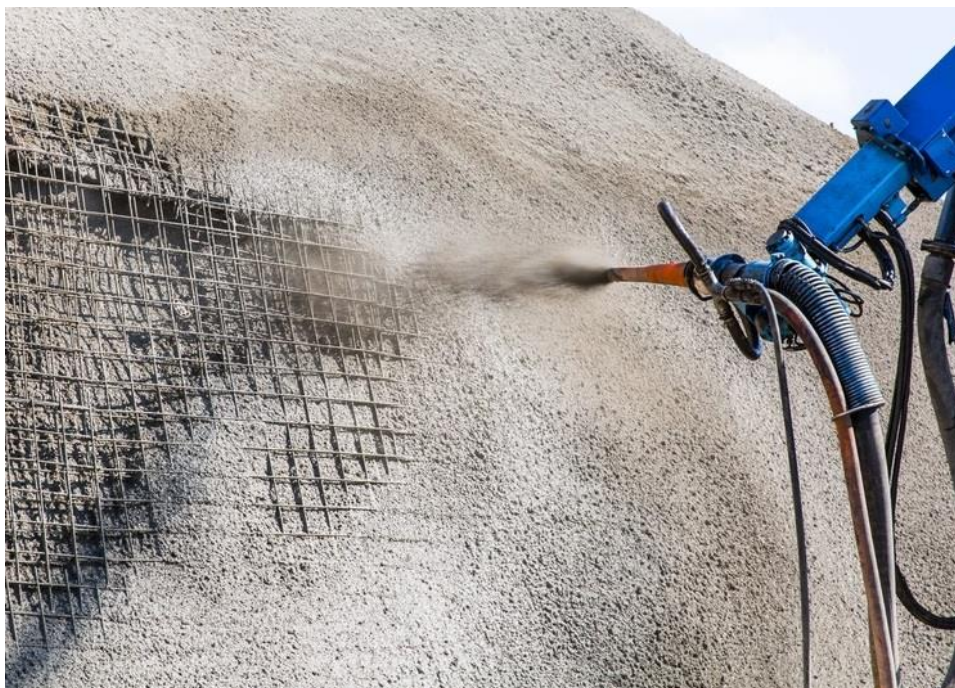
Рисунок 3 – Процесс торкретирования.
