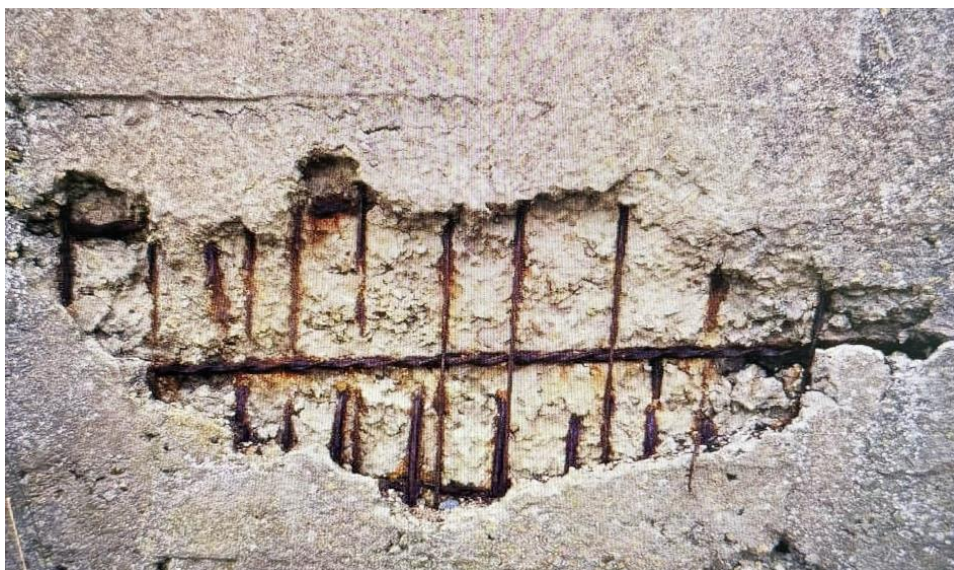
Рисунок 5 – Сульфатная коррозия
