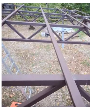
Рисунок 59 – Установка и сварка обрешётки
