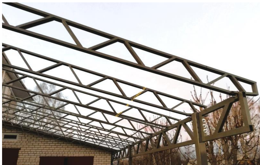
Рисунок 57 – Установка и сварка поперечных ферм с продольными фермами
