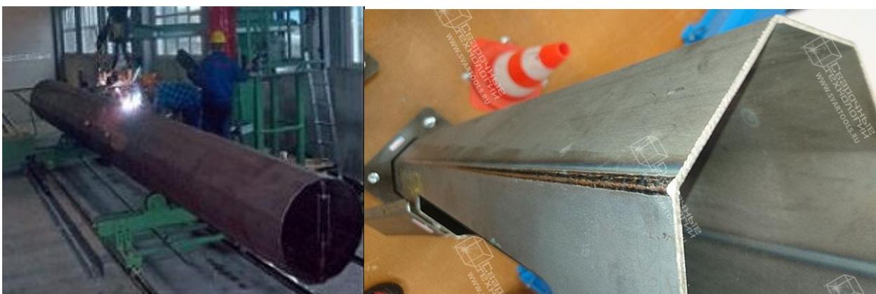
Рисунок 7 – Сварка продольного шва на многогранной опоре
