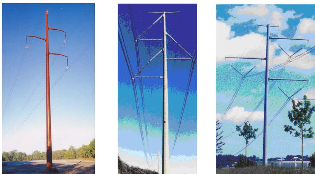
Рисунок 1 – Примеры устройства многогранных сварных опор
