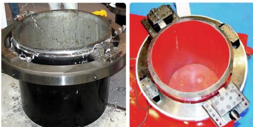
Рисунок 16 – операция резки и снятия фаски с применением трубореза
