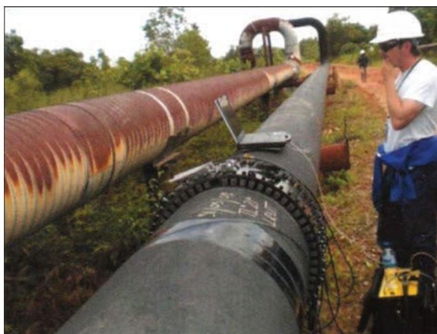
Рисунок 23 – Проведение низкочастотной ультразвуковой диагностики
