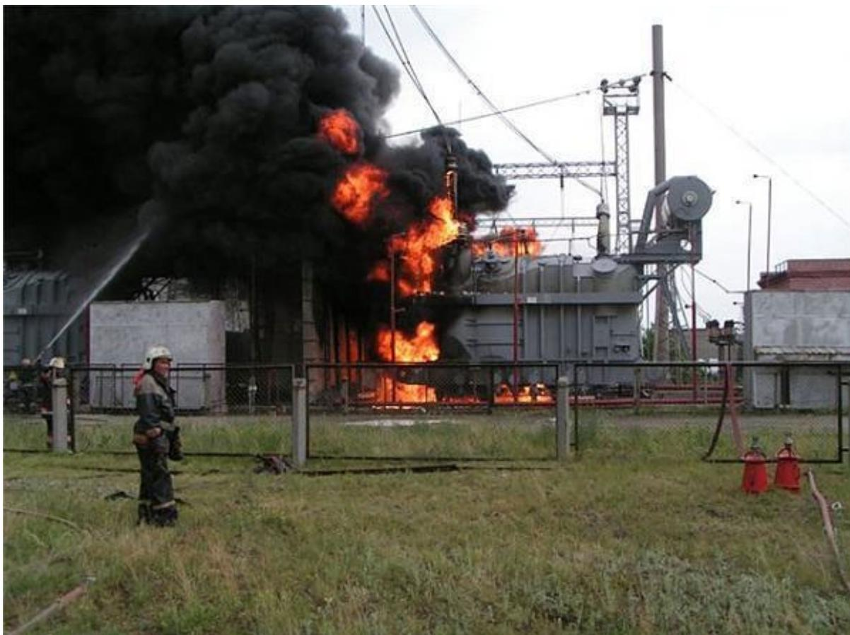
Рисунок 13 - Возгорание в силовом трансформаторе ПС Чагино
