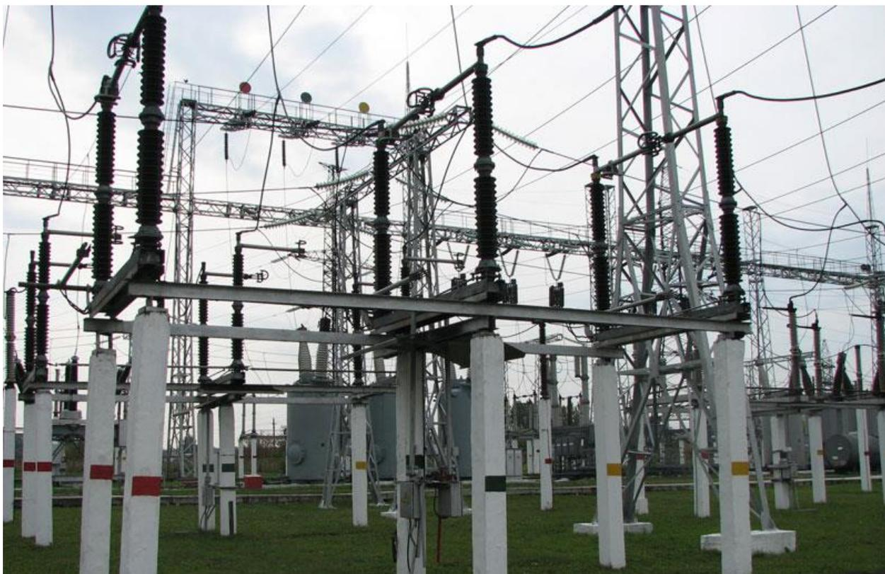
Рисунок 16 - Разъединитель 220 кВ
