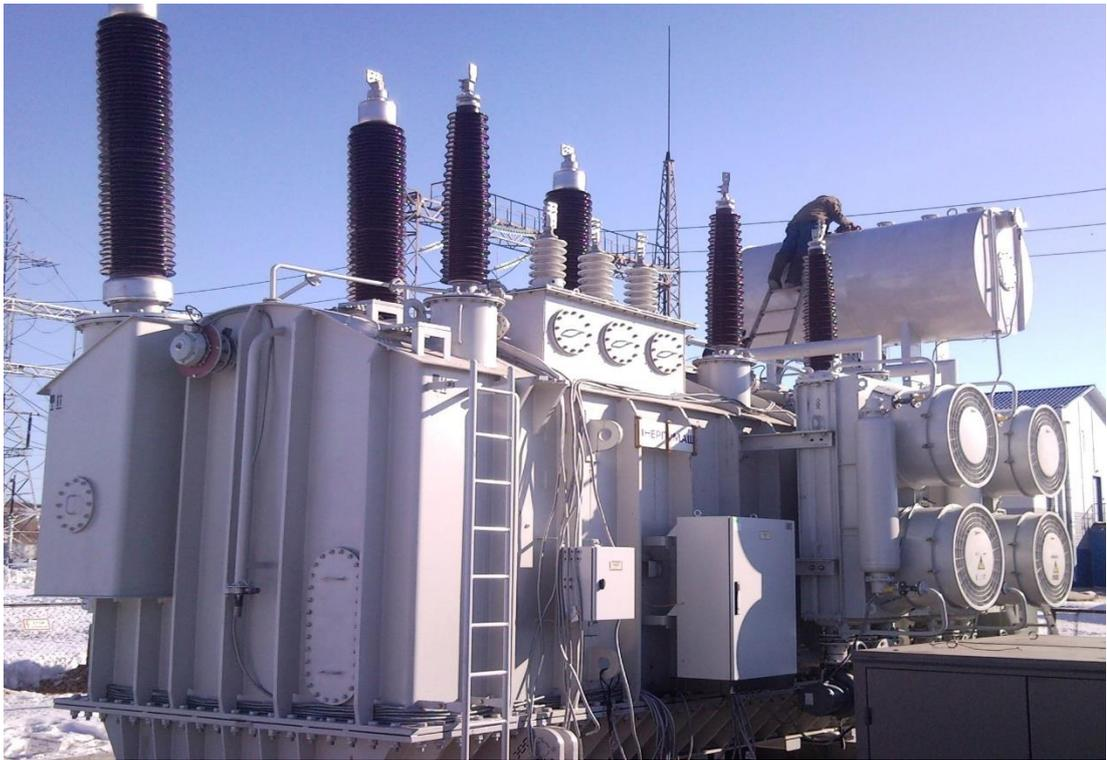
Рисунок 14 – Трансформатор типа АТДЦТН
