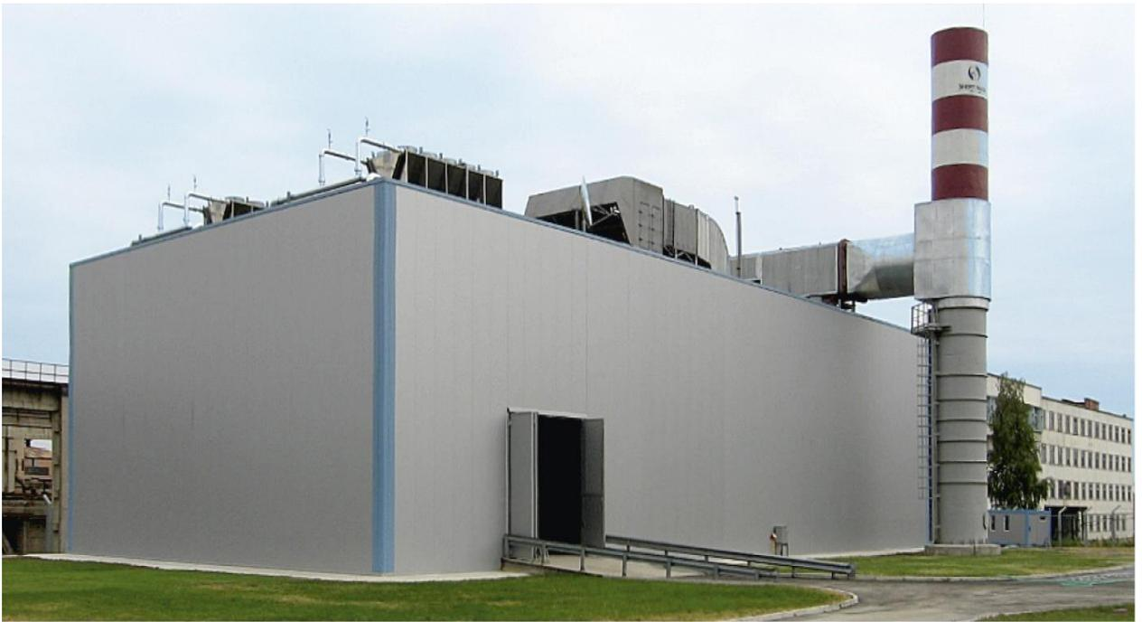
Рисунок 1 - Газотурбинная ТЭЦ серии ГТ ТЭЦ-009 «Энергомаш»
