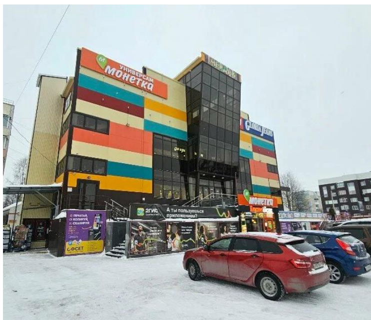
Рисунок 1 – Внешний вид здания ТЦ «Новый»
