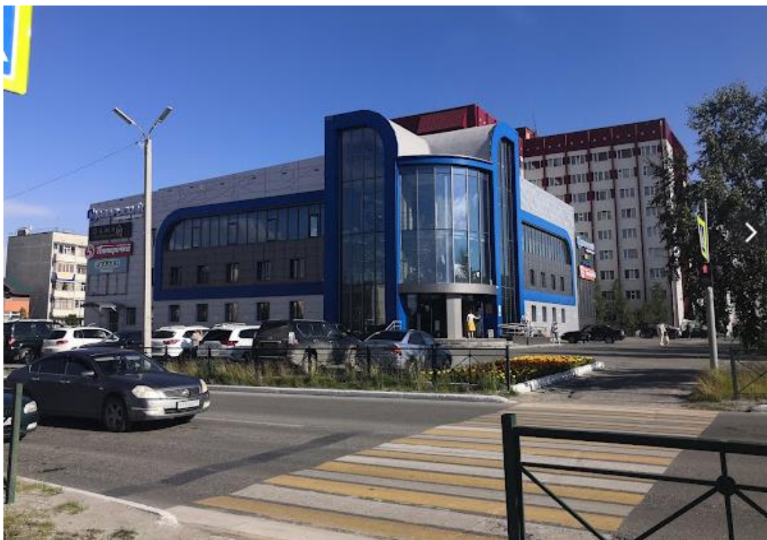
Рисунок 1 – Внешний вид здания ТЦ «Ноябрьский»
