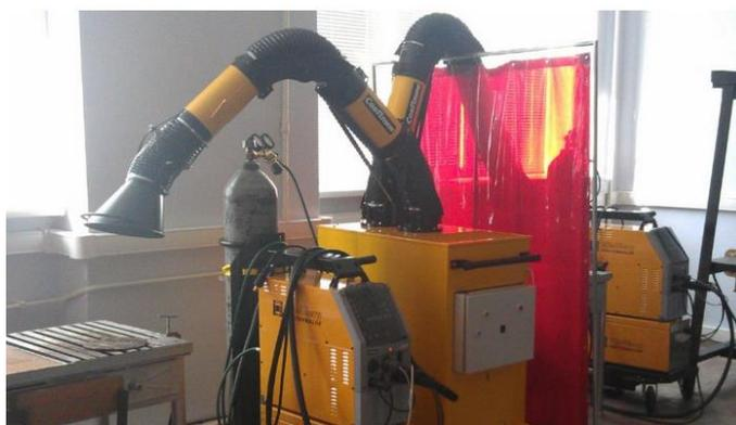
Рисунок 2 – Пример системы вентиляции над столами для газовой резки и сварки
