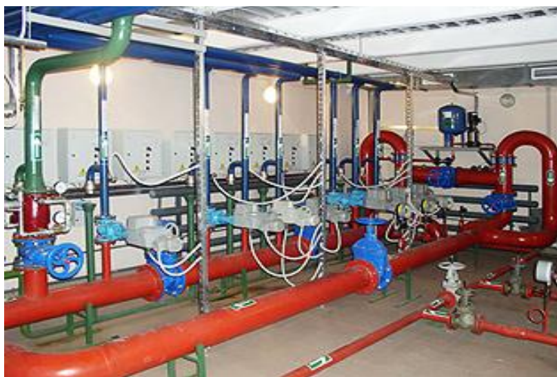
Рисунок 11 – Установка пенной системы пожаротушения
