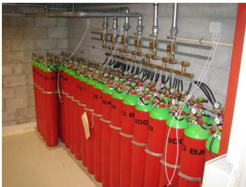
Рисунок 12 – Установка газовой системы пожаротушения
