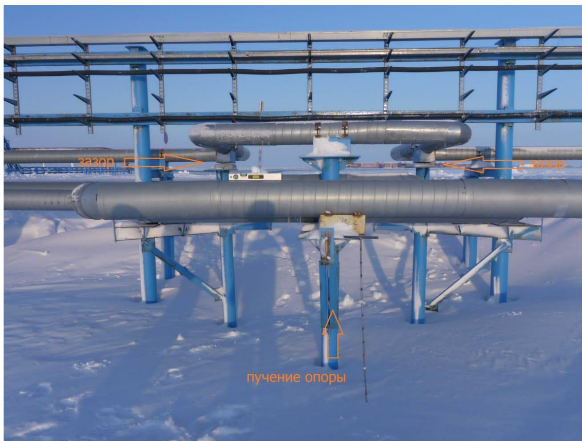
Рисунок 5 – Результаты осмотра газопровода
