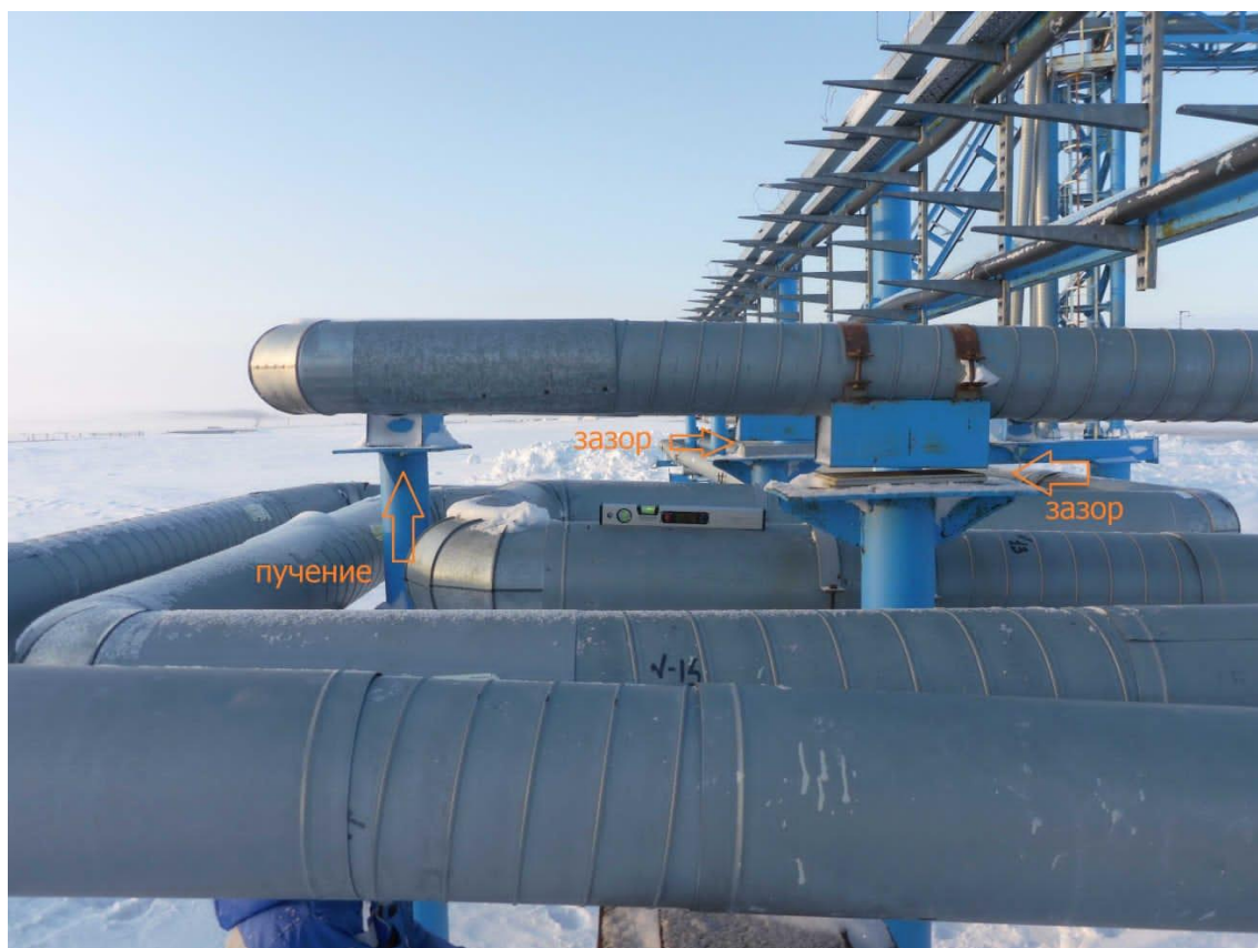
Рисунок 4 – Результаты осмотра газопровода
