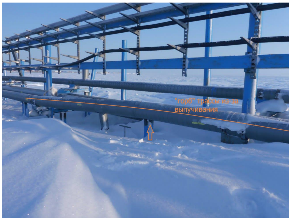
Рисунок 3 – Результаты осмотра газопровода
