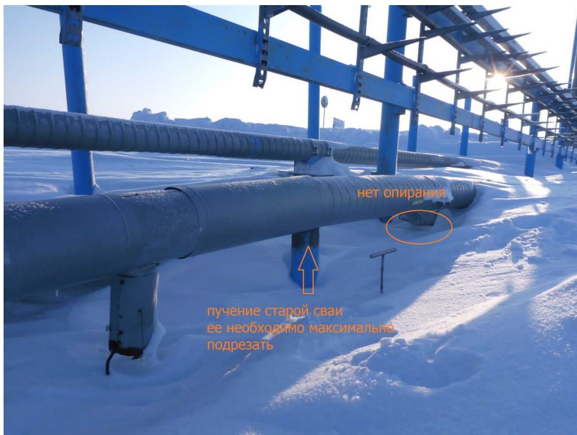
Рисунок 6 – Результаты осмотра газопровода
