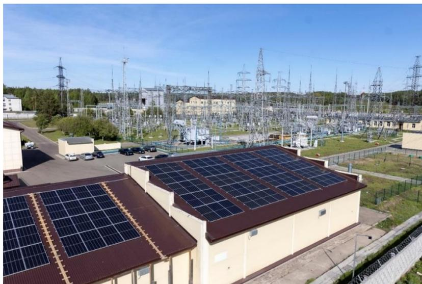
Рисунок 16 – Солнечная подстанция для обеспечения СН ПС Киндери
