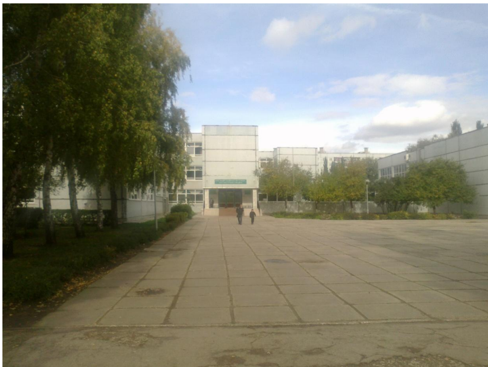
Рисунок 1 – Главный вход, вид с южной стороны здания.
