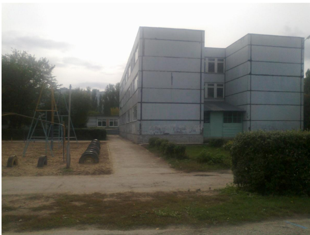
Рисунок 2 – Вид с северной стороны здания
