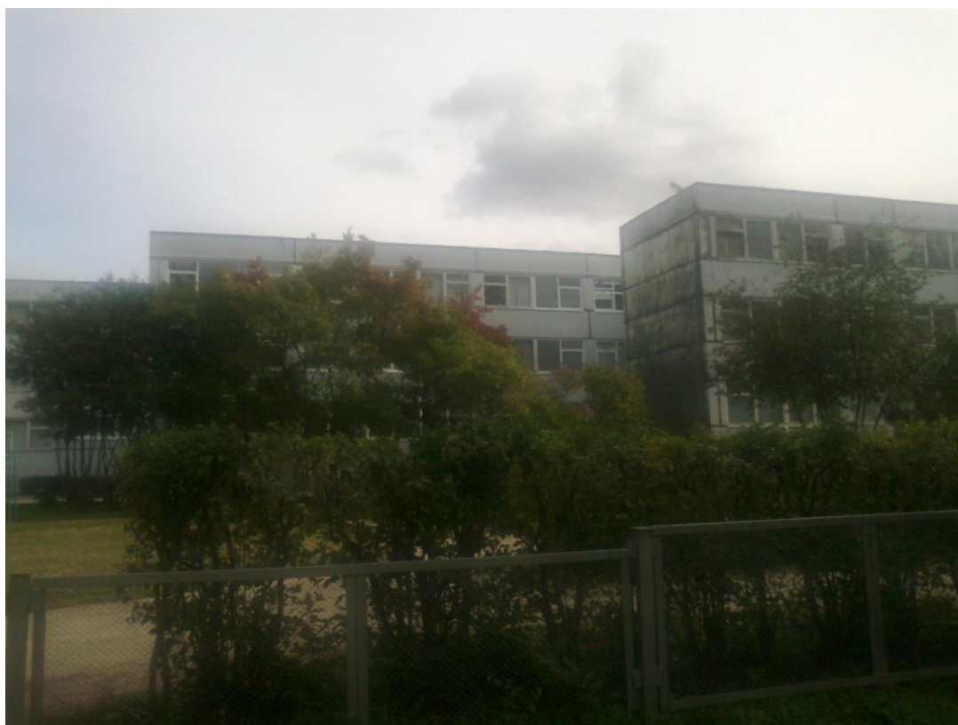
Рисунок 3 – Вид с западной стороны здания
