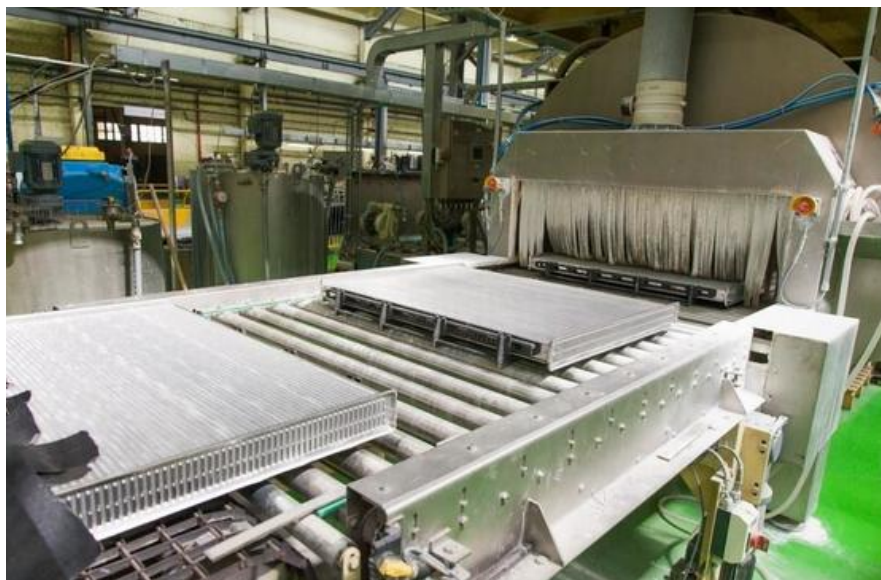
Рисунок 7 – Нанесение флюса при тепловой обработке
